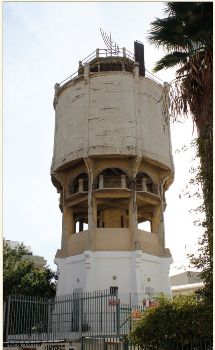
A Maze-torony, a hanukia , málló beton és kiálló rozsdás vas, a torony mellett veszélyre figyelmeztető tábla; Snir Stern felvétele
