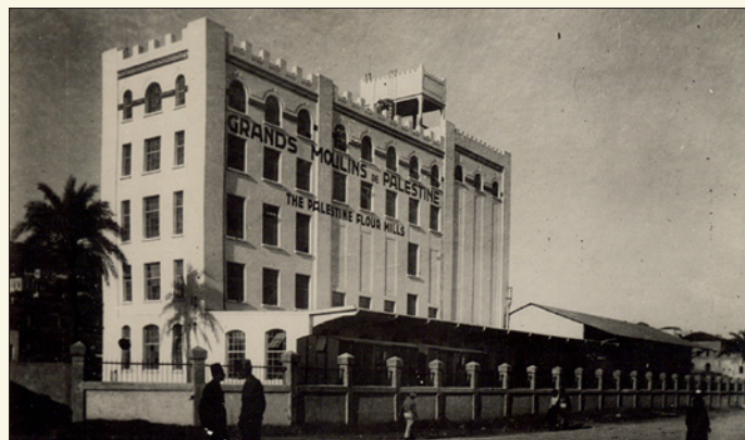
A malomépület észak-keleti homlokzata; mgt.
